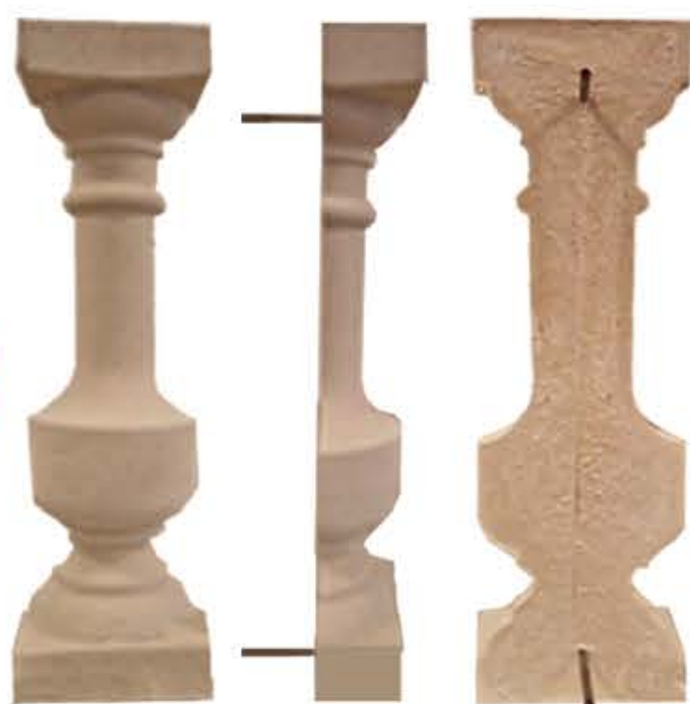
Reproduction à l'identique de de 1/2 balustres pour façade ancienne.
