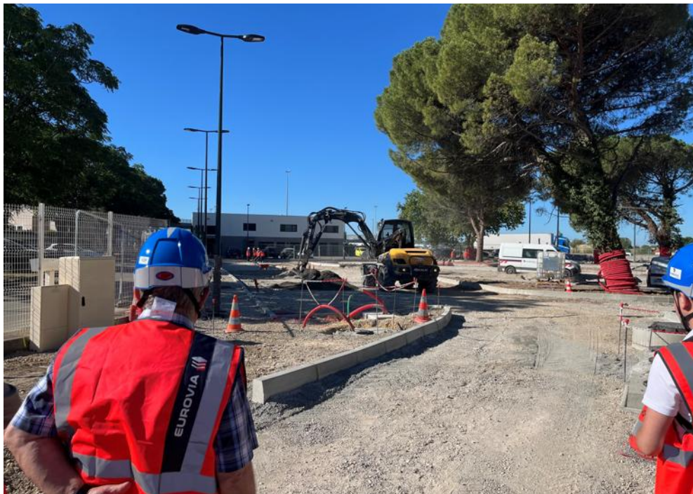
Le chantier se poursuit et le futur parking de covoiturage du péage d'Avignon Nord devrait être complètement terminé à la fin de la saison estivale. Photo Le DL/Sébastien Fuster
