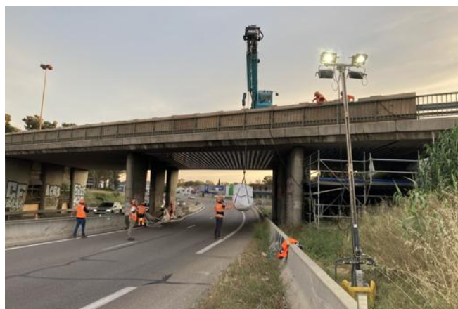
Les travaux sur le pont de la RD225 Avignon/Carpentras nécessitent une interruption du trafic de nuit. Photo Département 84
